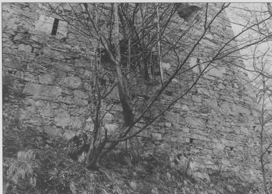
Sl. 11. Spodnji del vzhodnega pročelja. Levo in desno ob razrušenem portalu sta režasti okenci za pritlična shrambna prostora. Desno spodaj so vidne brunčnice zidarskega odra (prim. sl. 4). ♦ Bottom part of the eastern facade. To the left and right of the destroyed portal are the slot windows of the ground-floor storage rooms. Bottom right: timber holes of the scaffolding (see ill. 4). ♦ Vue de la partie basse de la façade est. A gauche et à droite du portail détruit il y a deux petites fenêtres à fente des pièce de dépôt du rez-de-chaussée. A droite en bas on distingue des trous dans le mur extérieur pour les poutres d'échafaudage (comp. ill. 4).
