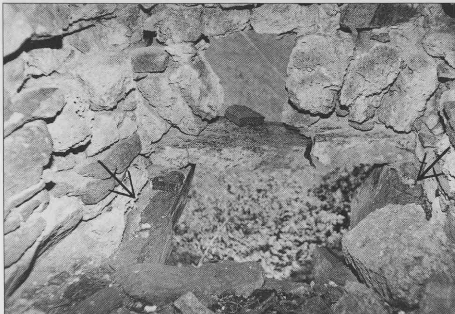
Sl. 24. Pogled na sedežni del v pomolnem delu stranišča. Puščici kažeta polici na pomolnih konzolah, na katerih je ležala sedežna plošča. Prepoznaven je fragmentarno ohranjen razbremenilni lok v severnem zidu na pomolu. ♦ View of the seat in the toilet's projecting part. The arrows indicate the shelves on projecting brackets, on which the seat rested. Also discernible are fragments of the buttress in the northern wall of the bay. ♦ Vue du siège dans les latrines en saillie. Les deux flèches montrent les deux étagères sur les consoles en saillie sur lesquels reposait la planche du siège. On peut remarquer la voûte à décharge conservée par des fragments dans le mur nord de la saillie.
