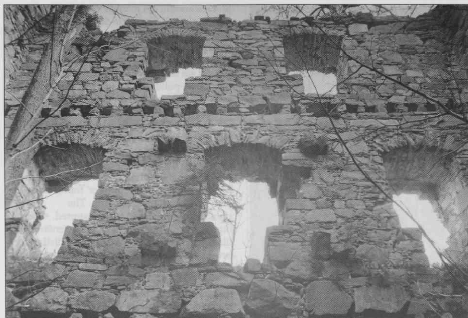
Sl. 15. Pogled na notranjo stran vzhodne obodne stene v prvem in drugem nadstropju. Lepo so vidni sidrni kamni za predelne steni v prvem nadstropju in odlično ohranjena vrsta tramovnic za podnike drugega nadstropja. ♦ View of the interior side of the eastern peripheral wall in the first and second floor. Distinct are the anchor stones of the dividing wall in the first floor and a row of excellently preserved holes for the floor joists of the second floor. ♦ Vue de la partie intérieure du mur de margelle est au premier et au second étage. On peut bien voir les pierres d'encrage de deux cloisons au premier étage et une série de trous dans le mur très bien conservés pour les planches du sol du second étage.
