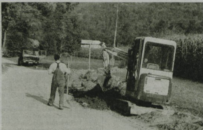
Začetek del pri polaganju telefonskih kablov ob cesti Blagovica-Česnjice foto T. C.
