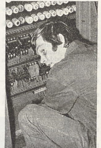
Dežurni električar mora večkrat v izmeni pregledati stikalne naprave in odstranjevati ugotovljene okvare.
