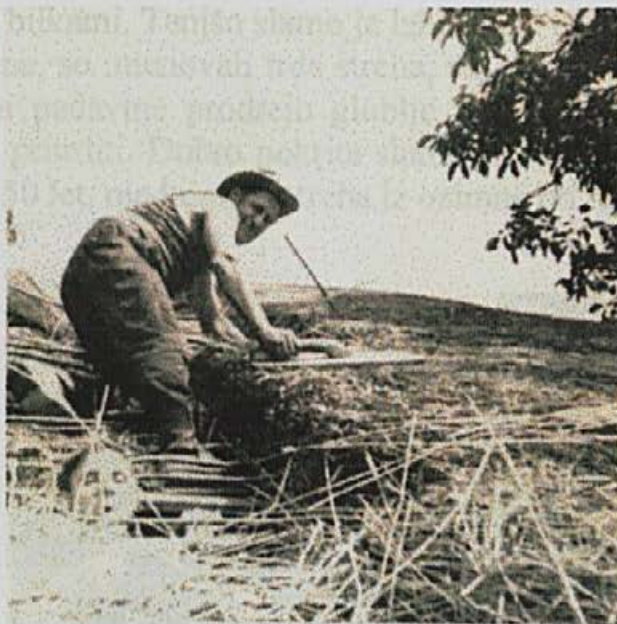
Slika 8: Glajenje strehe in vidna igla (slika last Šega Anton)
