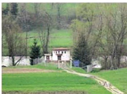
Slika 24 • Črpališče za pitno vodo na Kolpi pri Vinici
