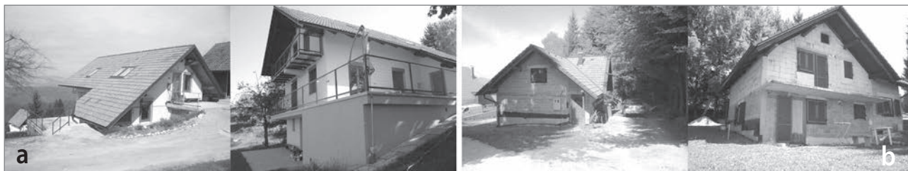
Slika 3: (a) Obnova in dozidava počitniške hišice na nagnjenem terenu, (b) obnova starejše počitniške hišice in dvig strehe na položnejšem terenu (foto: Tanja Oberžan)
