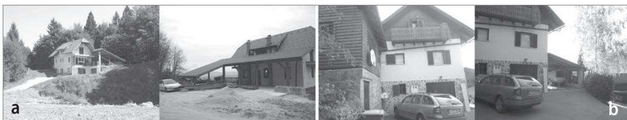
Slika 4: (a) Obnova počitniške hišice in dozidava objekta z vseh strani na nagnjenem terenu (garažni nadstrešek, garaža v hiši, gradnja nadstropja), (b) dozidava novega objekta ob obnovljeni starejši počitniški hišici (foto: Tanja Oberžan)
