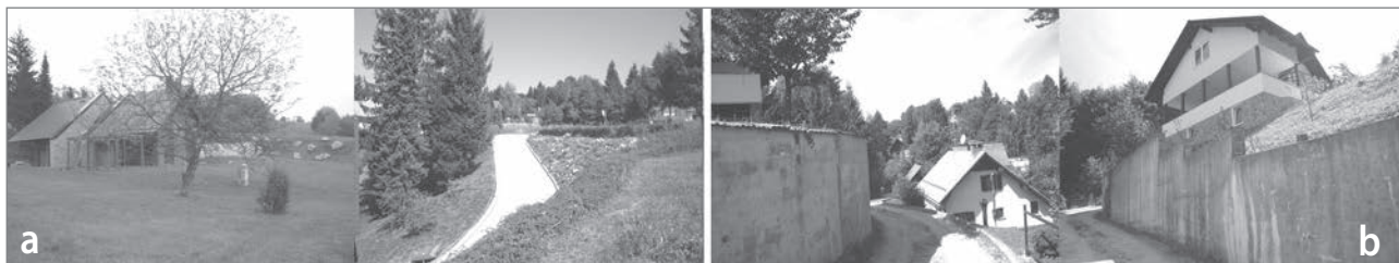
Slika 9: (a) Zatravitev in zasaditev brežine ali uporabe kamnov za reševanje višinskih razlik, ograditev parcele z živo mejo in ograjo ob vhodu, (b) betoniranje visokih opornih zidov in položitev strešne kritine na vrh betonirane brežine (foto: Tanja Oberžan)
