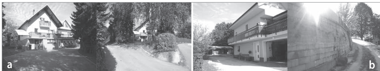
Slika 5: (a) Primerno dostopanje (razširjen asfaltiran dovoz, speljan po terenu z manjšim naklonom), (b) primer slabega dostopanja (neurejen, zarašččen, peščen, ozek, strm naklon do hiše) (foto: Tanja Oberžan).
