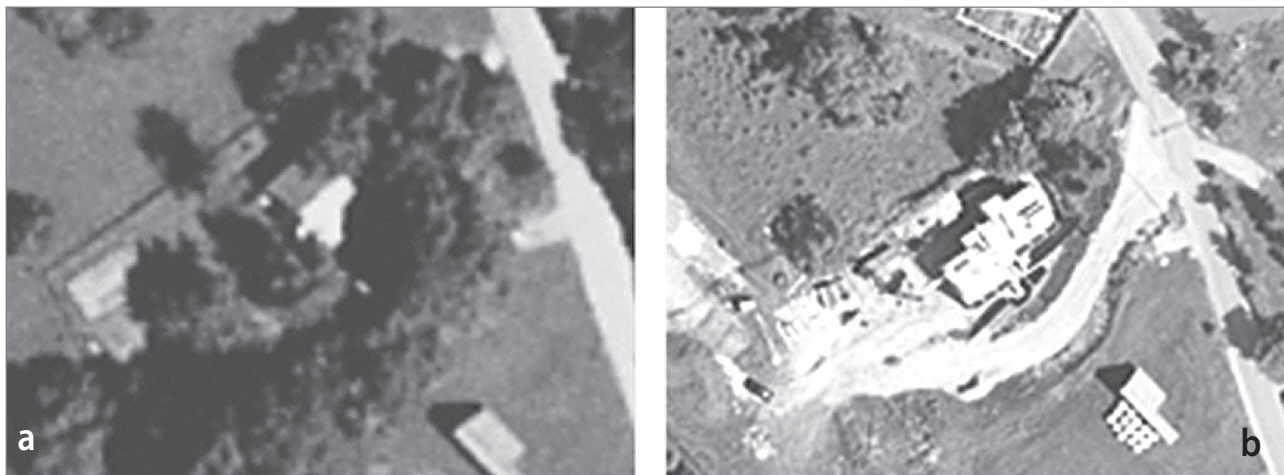
Slika 1: (a) Počitniška hišica na Polževem leta 1998 na parceli, zaraščeni z vegetacijo, (b) počitniški objekt leta 2006, vidna adaptacija počitniške hišice z gradbenimi posegi: odstranjena vegetacija, utrditve brežine z betoniranjem, nova širša in položnejša dostopna cesta (vir: GURS, 2010).
