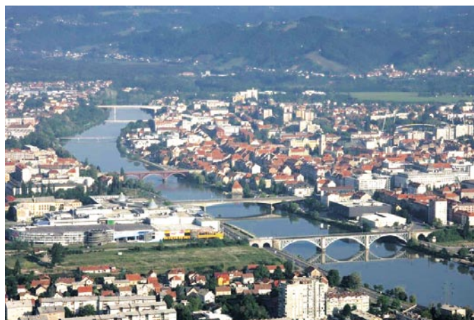
Slika 12 • Od zgoraj navzdol: Koroški most, Studenška brv, Stari, Titov in Železniški most
