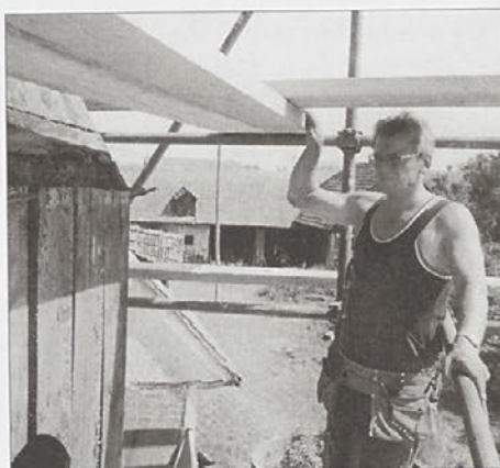
Velik "prostovoljec" Franc z mislimi pri novem zvoniku – starega, dotrajajnega je treba zamenjati
