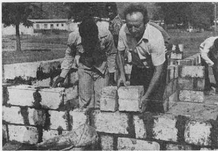
Giuseppe Burgnich pri gradnji poklicne tehnične šole v Kossou
