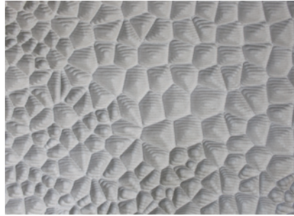
» Za rezkanje več kot 1,5 milijona tekočih metrov je bilo potrebnih več kot 1000 najkakovostnejših diamantnih rezkalnih orodij. | Slika: © www.hasenkopf.de
