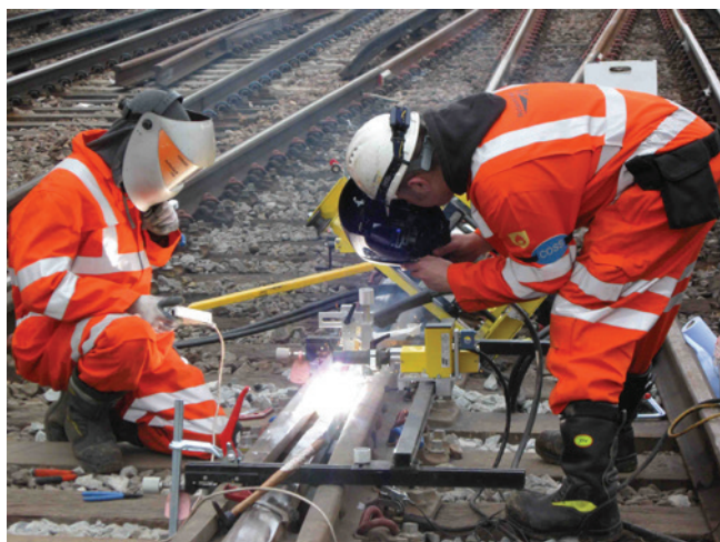
» Slika 1: Obločno varjenje z avtomatskim sistemom, ki se uporablja za obnovo železniške proge.
