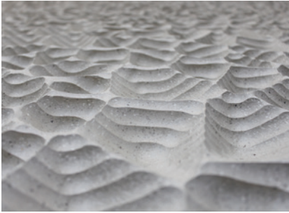
» Globina rezkanja strukture je bila od 5 do 90 mm. | Slika: © www.hasenkopf.de
