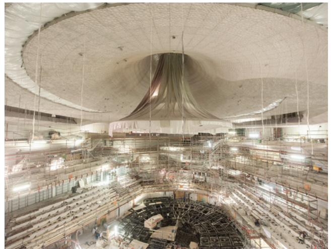
» Hasenkopf Industrie Manufaktur je za 6000 m 2 stenskih in stropnih oblog natančno obdelal 10 287 edinstvenih plošč iz mineralnega materiala. | Slika: © www.hasenkopf.de
