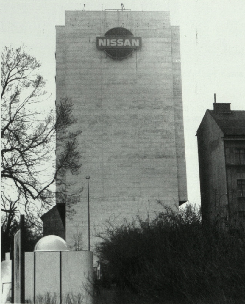
Slika 2: Slepa fasada stanovanjsko poslovne zgradbe "Kozolec" v Ljubljani (foto: T. N.).
