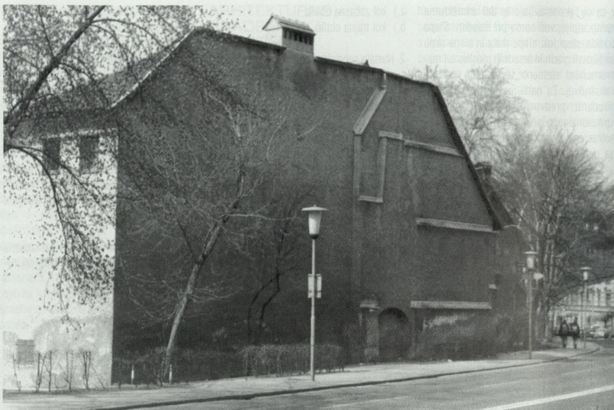
Slika 3: Požarni zid na Hrenovi 5, razkrit ob odstranitvi dela gradbene substance zaradi izgradnje oz. širitve Karlovške ceste v Ljubljani (foto:T.N.).
