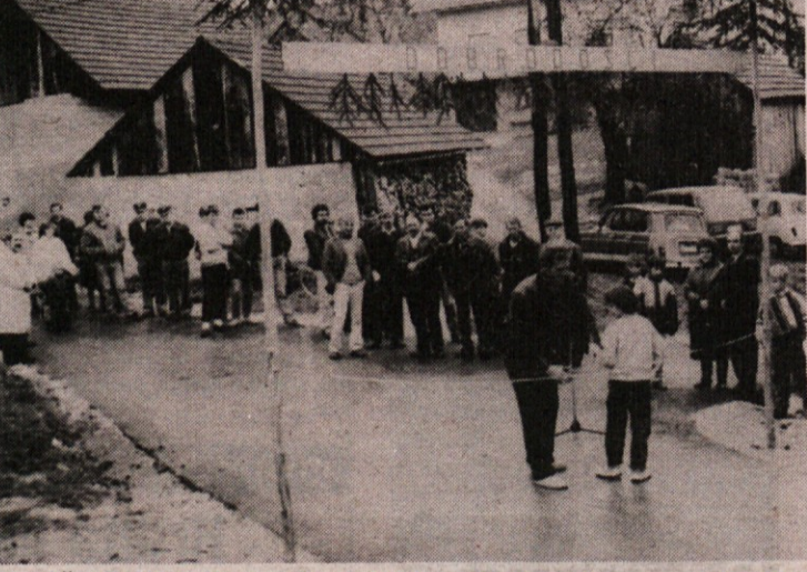
KONČNO LE ASFALT — Predsedniku gradbenega odbora za cesto na Mihovec, Francu Gazvodi, je pripadla čast, da je prerezal otvoritveni trak. (Foto: T. Jakše)
