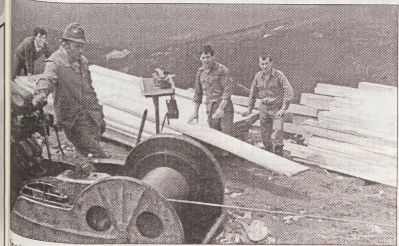
Snežnik, junij 1977. S tovorno žičnico z vitlom na Snežniku so planinci spravili z Obračališča na vrh okrog 120 ton gradbenega materiala, potrebnega za nadzidavo planinske kočice.
