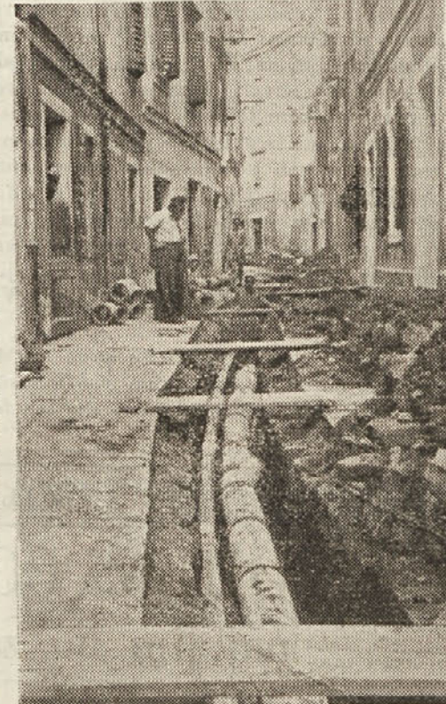
Vzpostavljanje kanalizacije v ul. Dante v Miljah.
