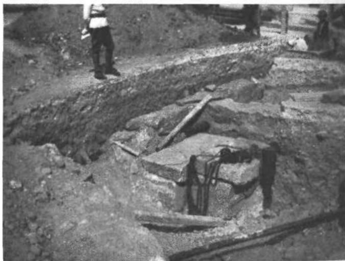
Rimska grobova pod cestiščem Groharjeve ulice v Ljubljani
