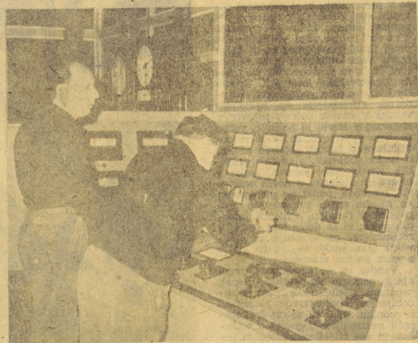
Komandna plošča parnega kotla, kapacitete 125 ton na uro
