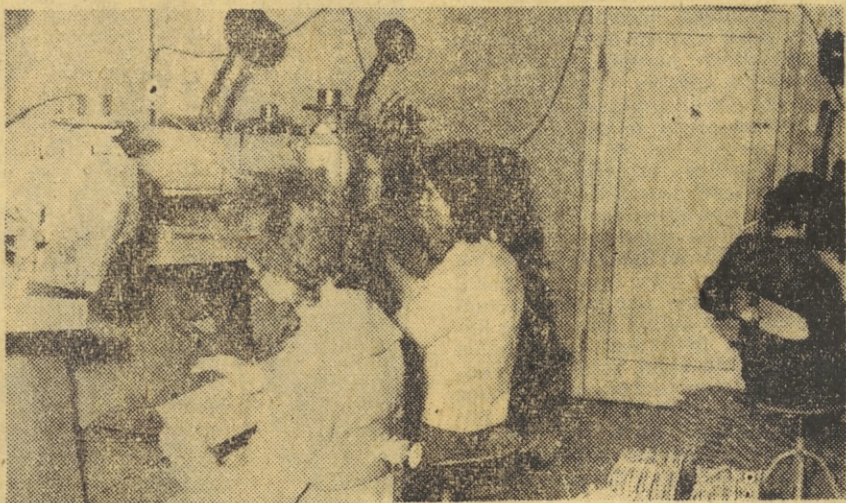
Tika: šivalni stroji za žico, ki jih v podjetju uporabljajo za šivanje kartonov in zaščitne valovite lepence
