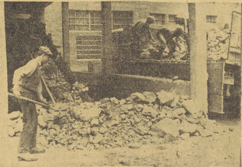
Cementarna Trbovlje: razkladanje tufa za izdelavo cementa
