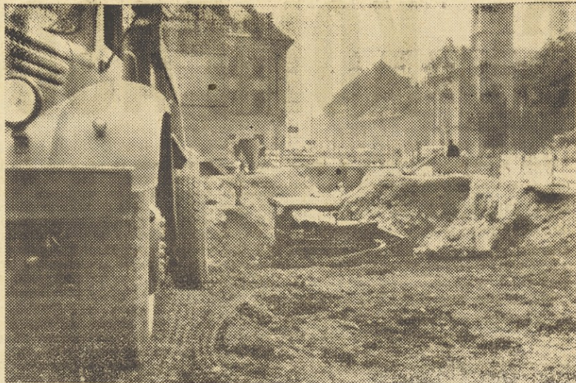
Pri gradnji podvoza v Ljubljani na Celovski cesti. Mehanizacija v polnem teku
