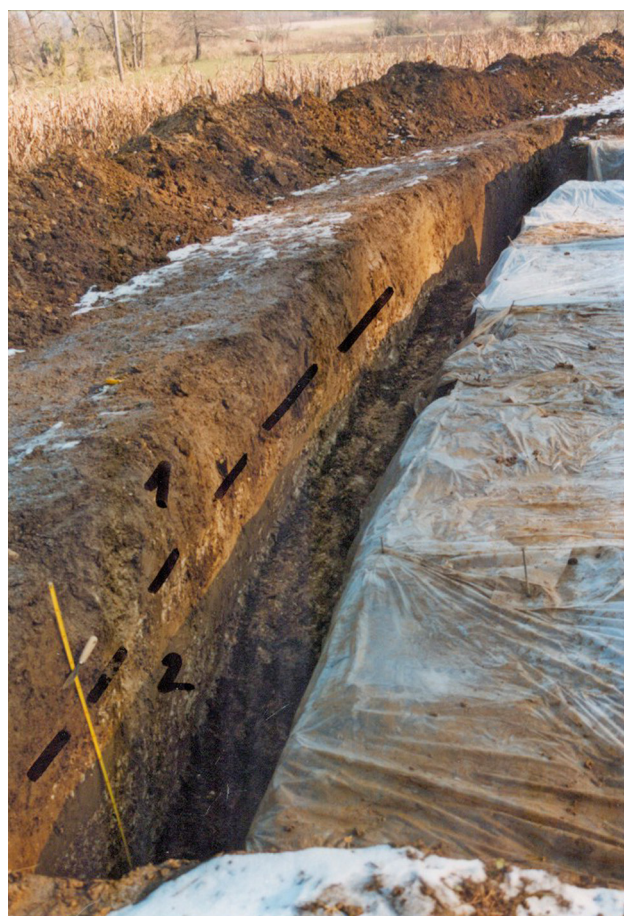
70 Zahodni del izkopa v smeri vzhod–zahod.
