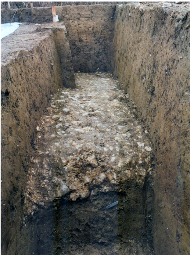
62 Nanos dolomitnega prod na aluvialnem vršaju v izkopu.
