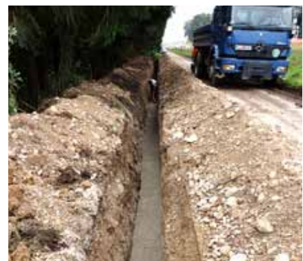
Pripravljena kvalitetna podlaga za cevi
