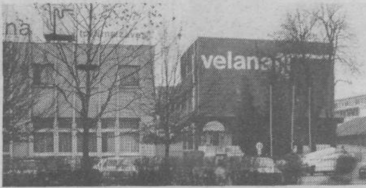
Pol leta novo proizvodno halo mogočni kostanji nekako zakrivajo, ko pa odpade listje, se pokaže pročelje. Foto: J. P.
