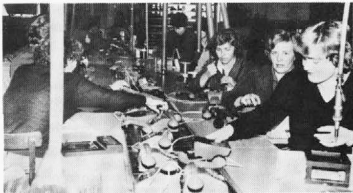
Tako izgleda montaža telefona na tekočem traku
