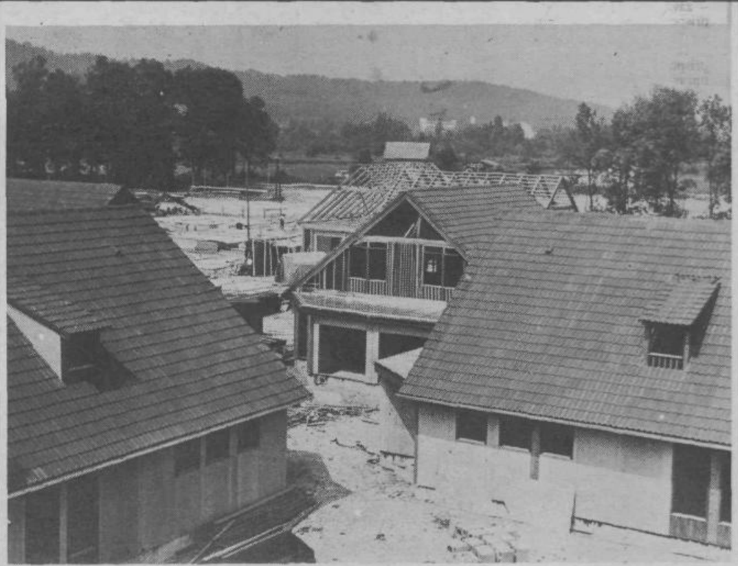
Montažno naselje v Sneberjih hitro raste iz tal. Hiše bodo vseljive predvidoma že v decembru
