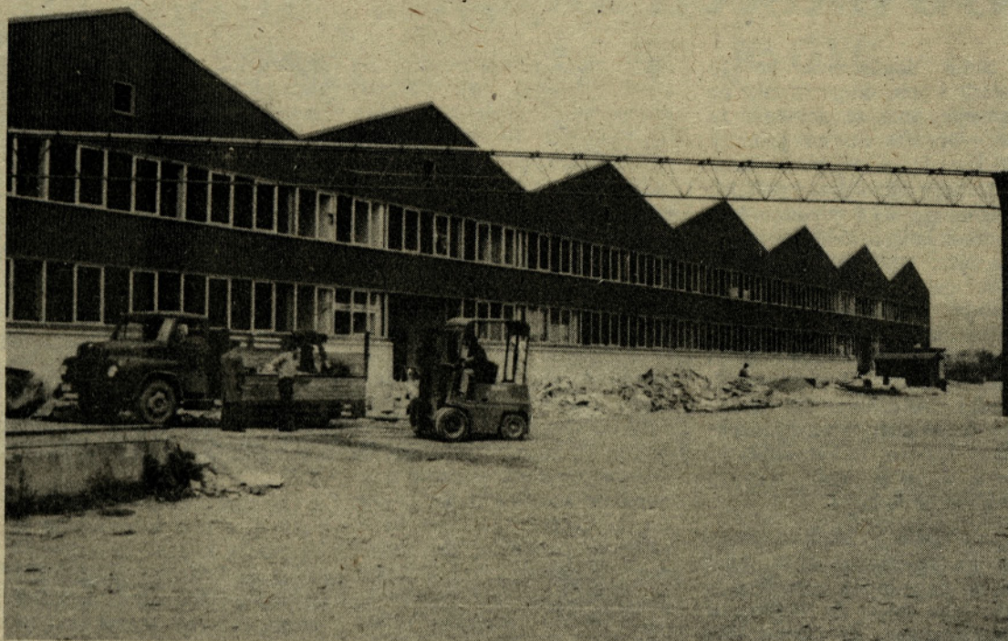
Nova tovarna kmetijskih strojev SIP Šempeter pod streho.
