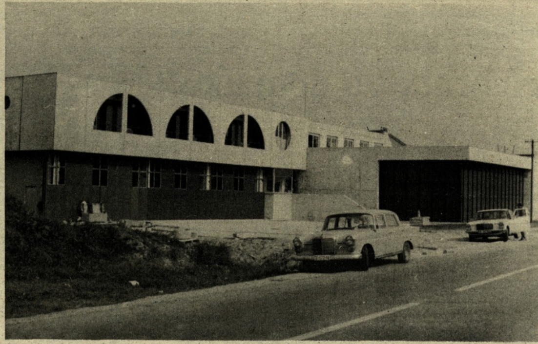
Posnetek kaže nov gasilski dom v Žalcu pred otvoritvijo.
