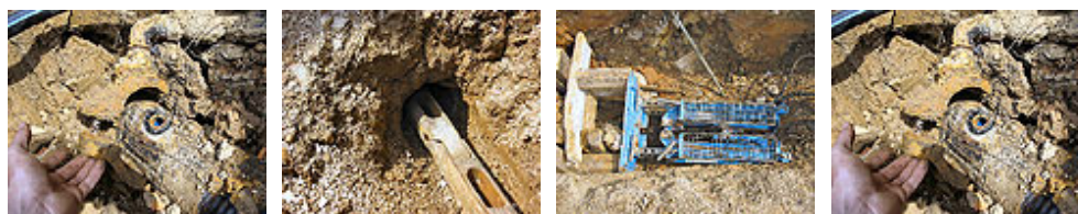
Privzeta slika 18: Metoda Groundburst v praksi – Vilkgograd
