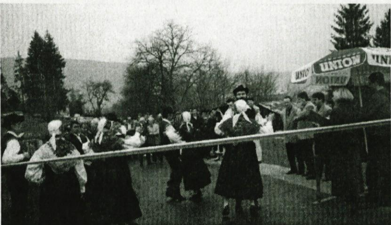
Plesalci folklorne skupine s Krke so zaplesali kar na novem asfaltu. Po odprtju ceste pa smo se vsi skupaj v dolgi koloni odpeljali na Korinj in se tam z vaščani povesečili ob novi pridobitvi.
