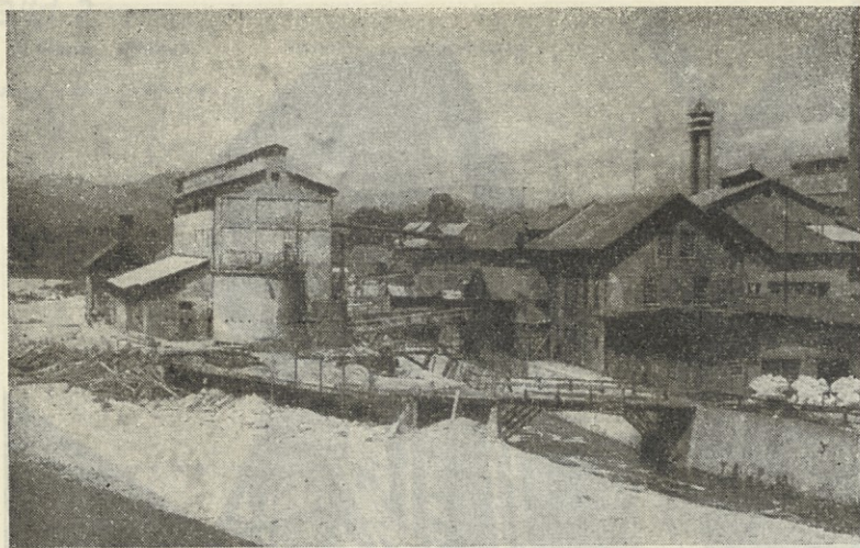
MEDVODE — Stari del naše tovarne. Vendar je med tem časom že prišlo do nekaterih sprememb, predvsem glede ureditve prehodov, mostičkov in cevnih ter žičnih vodov. Prav tako postopno urejamo tudi fasade (V. B.)
