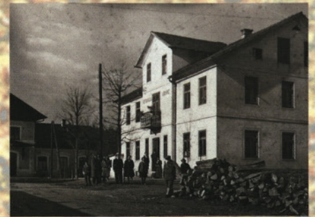
Medvode, gostilna Bohinc pri železniški postaji
