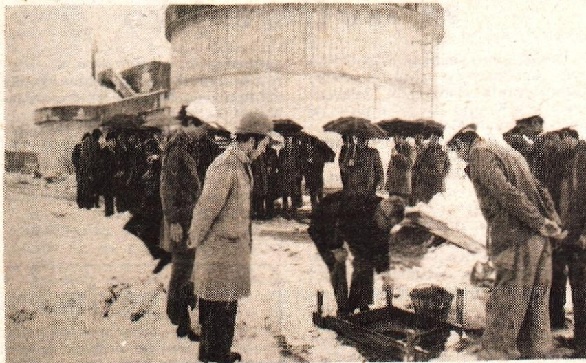
Predsednik medobčinske gospodarske zbornice za Gorenjsko Franc Podjed je vzdal temeljni kamen za drugi del čistilne naprave v Škofji Loki. - Foto: F. Perdan
