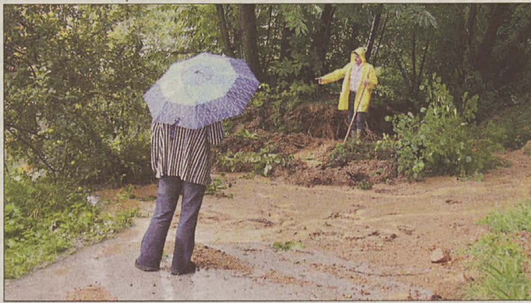
Takole se je zaradi sproženega plazov na Ledini končala cesta, ki naj bi služila kot obvoznica za Orehovo. Plaz so interventno uredili lani, tako da so omogočili prehodnost ceste.
