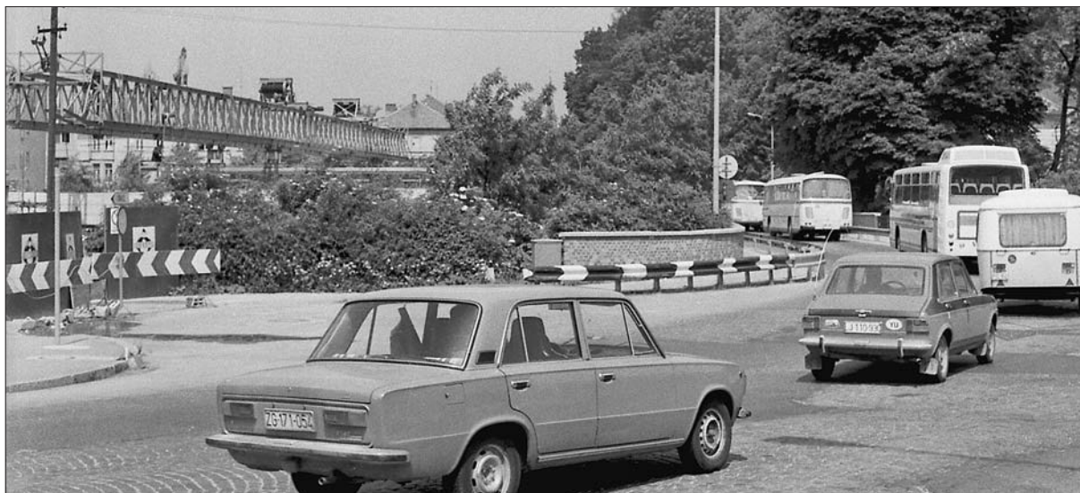
Zgoščen promet na starem Karloškem mostu, na levi pa je vidno, kako napreduje gradnja novega mostu, junij 1977 (foto: Marjan Ciglič; hrani: Muzej novejšje zgodovine Slovenije).
