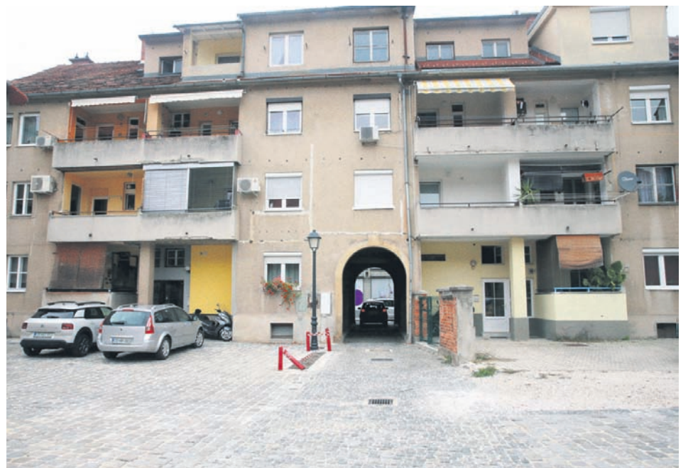
Na okopih, ki so ob prenovi Muzejskega trga prav tako doživeli lepoto preobrazbo, je na novo urejeno parkirišče za stanovančce na tem območju. Dostop do parkirišča iz Gosposke ulice je mogoč skozi podhod, kjer bo v začetku novembra začel delovati potopni stebriček.
