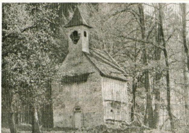
Pravzaprav je zob časa sam načel fasado propadajoče kapele, še preden so se je lotili s strokovnimi kladivci. Izpod fasadnega ometa se je pokazala lepa romanska zidava s kamni povezanimi z značilnim romanskim fugiranjem. Na stranski zunanjih steni se je izpod ometa prikazal stranski portal z monolitnim portalnim lokom. Tudi stransko okroglo okno izklesano iz enega kosa kamna je pričalo, da bi bila stavba lahko postavljena daleč pred letom 1645, kot je veljalo doslej.
