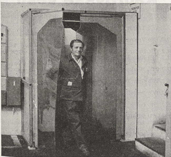
Na vseh prehodih oddelkov so montirani vetrolovi, ki preprečujejo vdor hladnega zraka v delovne prostore
