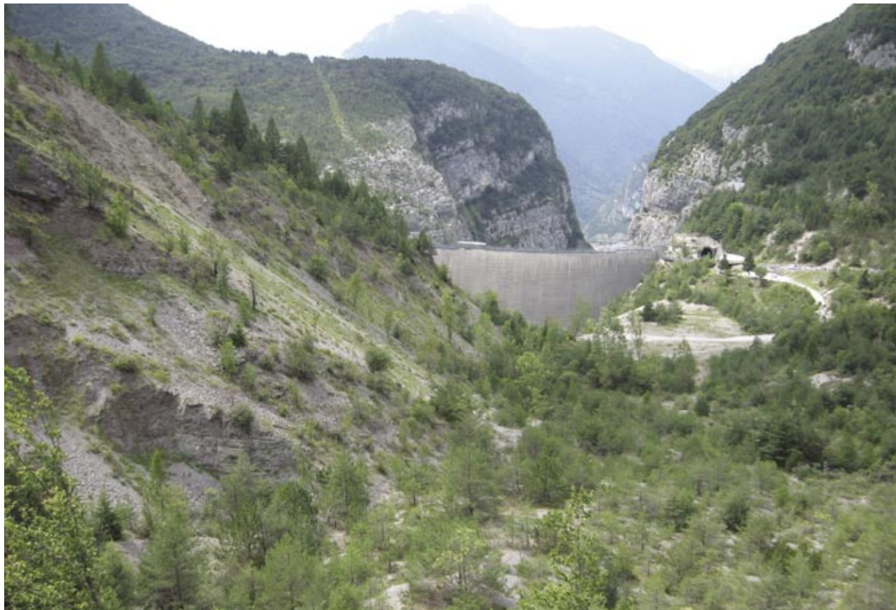
Slika 2: Pregrada Vajont pri mestu Longarone v SV Italiji. Na levi strani je hribina, ki je zdrsnila v zajezitivno jezero, "pljuski" vode je imel katastrofalne posledice. Višina pregrade na spodnji strani je 265 m; za primerjavo: najvišja slovenska HE Moste ima 60 m visoko pregrado (foto: Peter Frantar).
