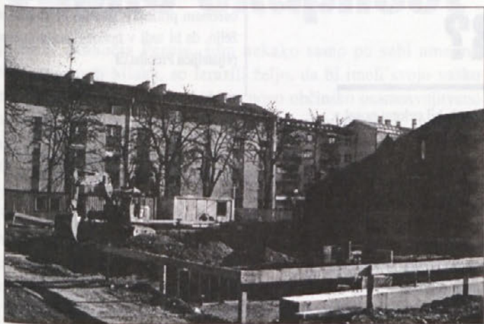
Radljski gradbinci so že zabetonirali temelje
