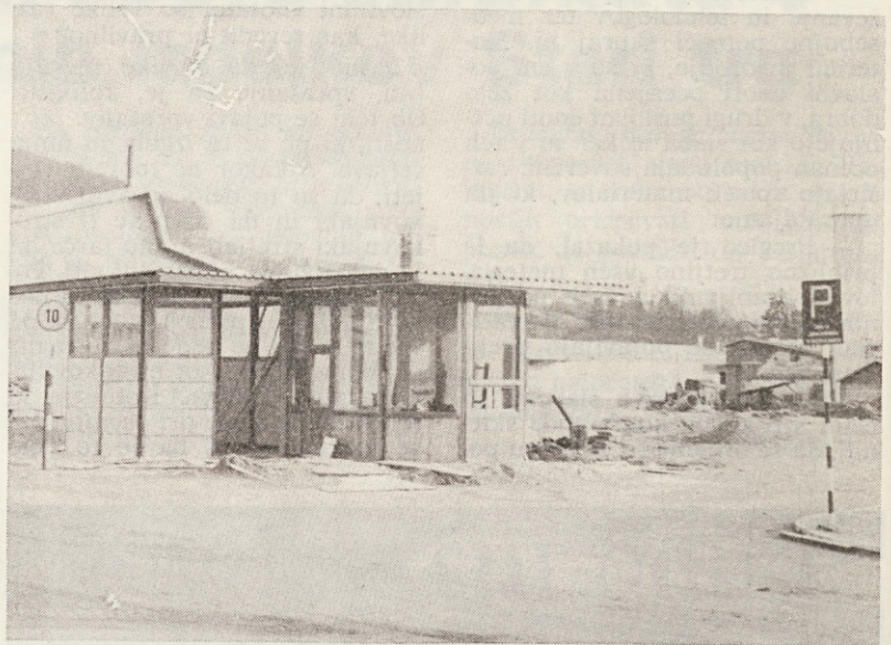
Nova vratarnica pri Tovarni ivernih plošč v Cerknici
