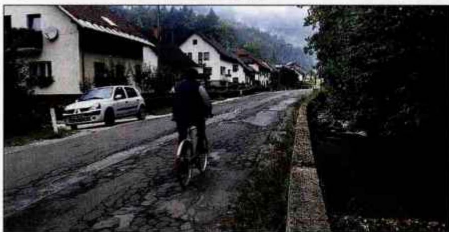
Začetek rekonstrukcije regionalne ceste skozi Log je bil napovedan že za poletne mesece, a se je zataknilo pri odkupu zemljišč, še zlasti tistih za pločnik, ki ga sedaj ob tej cesti ni. "Dela se bodo v vsakem primeru začela še letos, ne sicer na cestišču, začela pa se bo gradnja opornega zidu," je napovedal župan.
