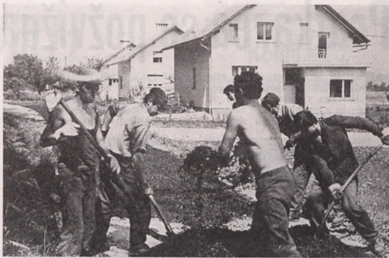
Gradnja ceste v Podpeči
