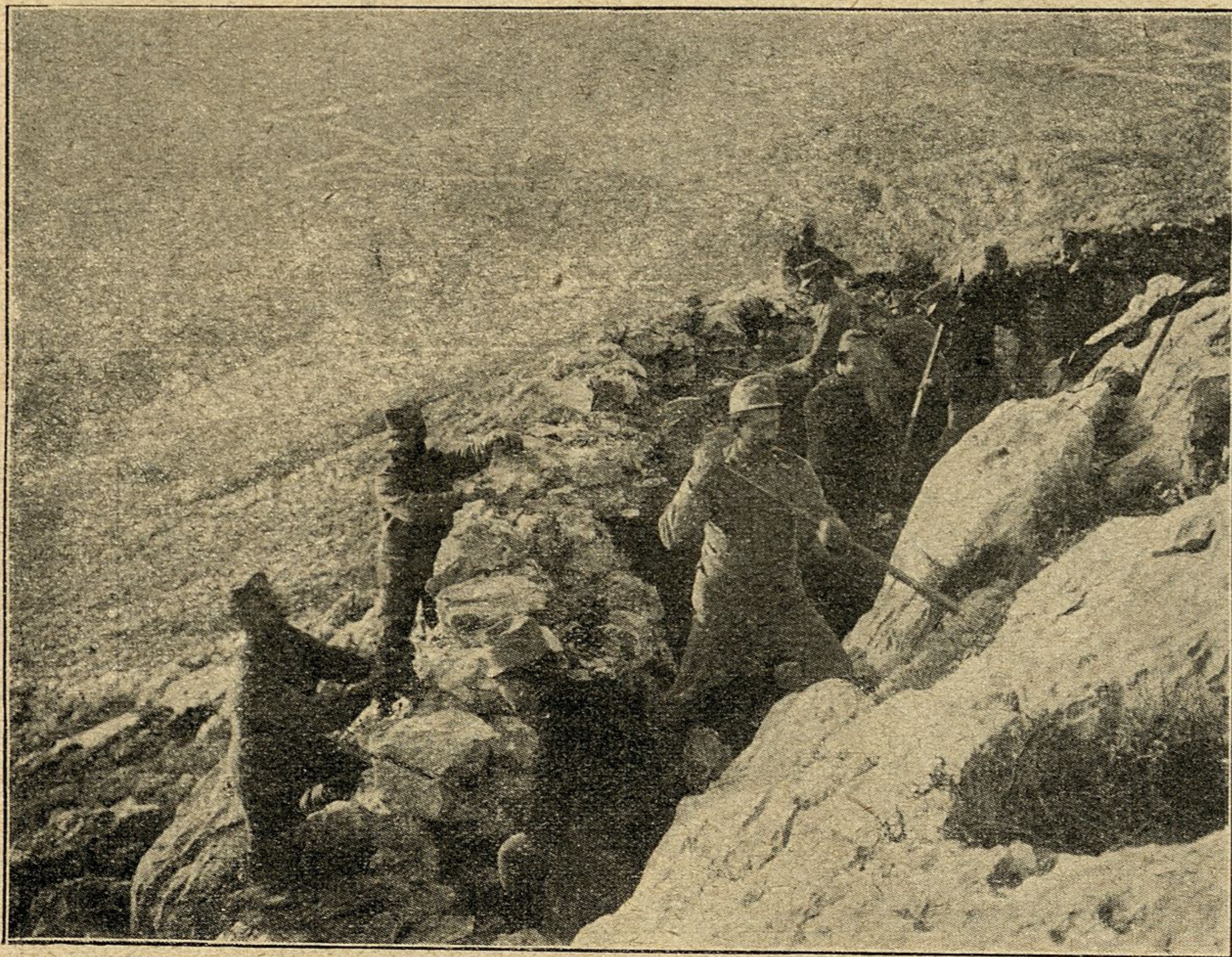
Befestigungsarbeiten im Karst der Herzegowina.
