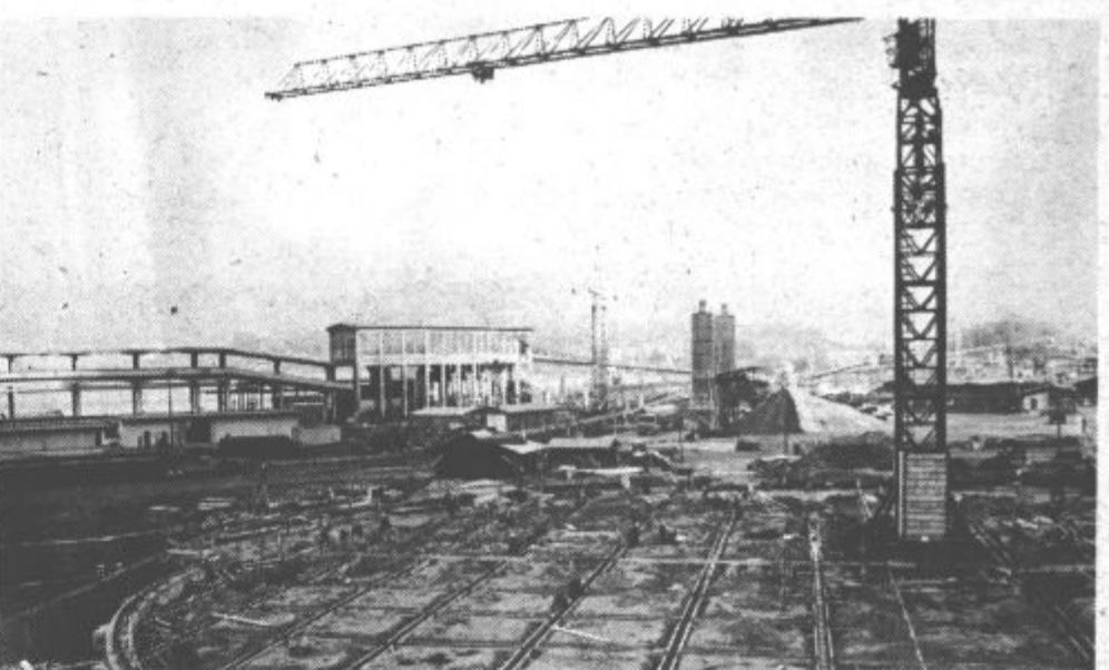
V Šoštanju je trenutno največje gradbišče v Šaleški dolini; Gradis – TOZD Celje je med drugim opravil izkopi in zabetoniral temelje za hladilni stolp nove Termoelektrarne Šoštanj 4.
