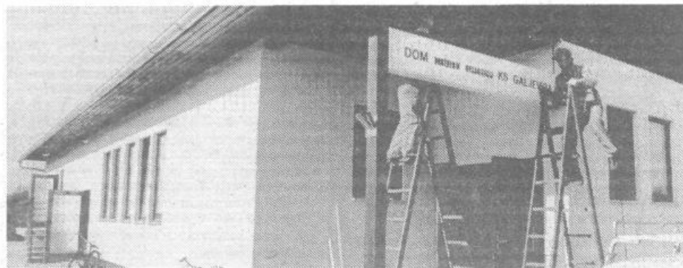
Prej je bila kot vsaka druga montažna hiša, zdej, z napisom, pa je postala tudi uradno dom krajanov KS Galjevica. In to je res njihov dom, saj so ga zgradili z lastnim delom in le z nekaj pomoči iz občinskega žaklja.
