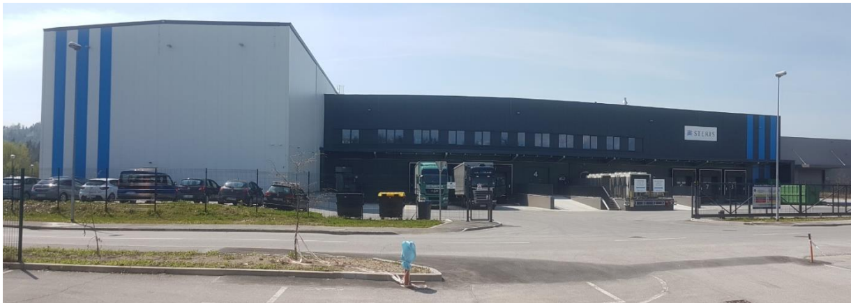
Slika 100: Poslovno proizvodni skladiščni objekt Steris (Foto: Inšpekcija URSJV)
