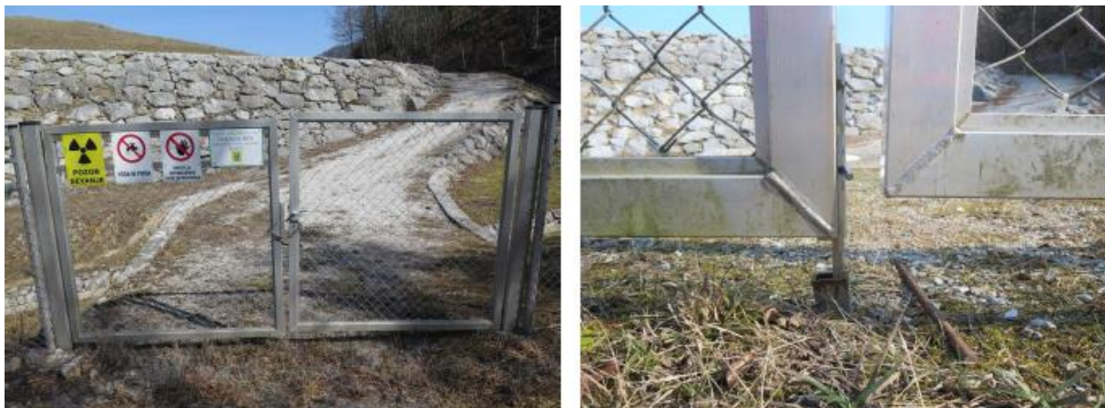
Slika 90: Premik vhodnih vrat pri severni dostopni cesti
