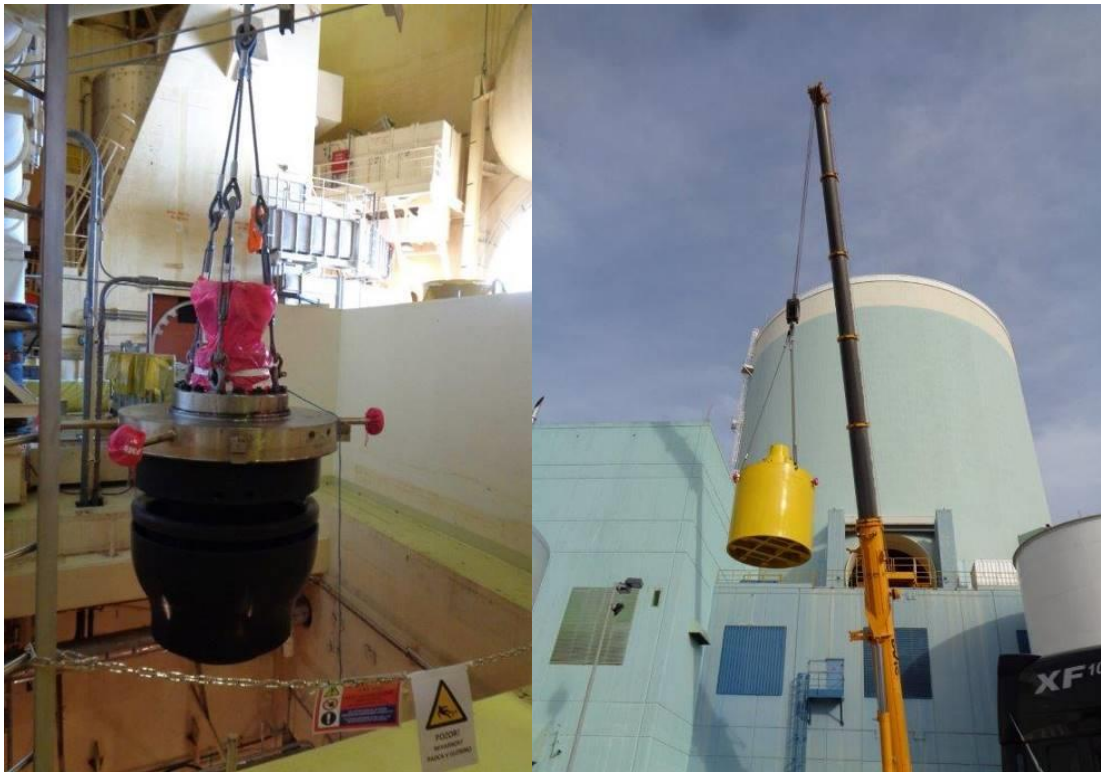
Slika 71: Dvig in transport hidravličnih delov RCP-2 (Foto: NEK)
