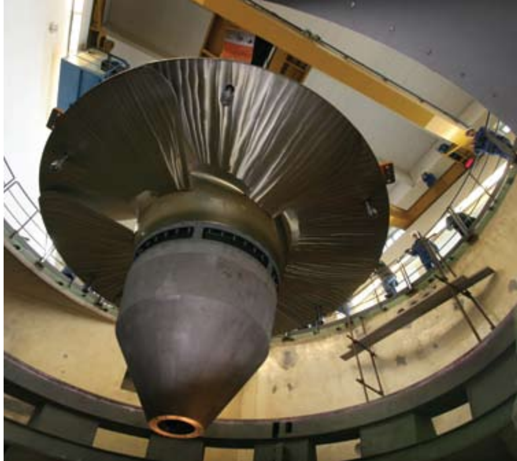
Nameščanje gonilnika za spuščanje v turbinski jašek.
