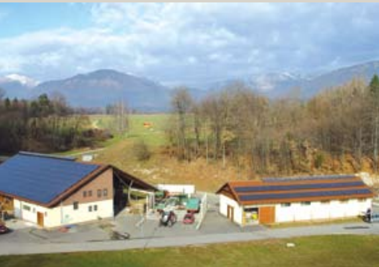
Fotovoltaična elektrarna Strahinj.
