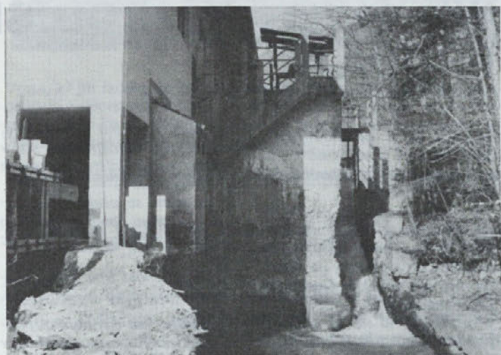
Ta iztok vode iz turbine v Preddvoru kaže le na to, da Jelovica tu zelo gospodarno izkorišča vodo, saj le ta poganja manjšo vodno elektrarno, ki daje velikokrat dovolj elektrike za potrebe vsega obrata. Vendar pa slika ne kaže tudi na umazanost vode, ki jo povzroča Jelovica nekoliko nižje. Za to pa vedo inšpektorji in potrebno bo zgraditi čistilno napravo.
