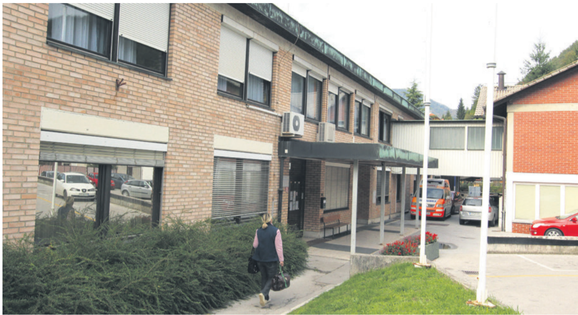
Zdravstveni dom Laško je med revizijskim postopkom sprejel ustrezne popravilne ukrepe za odpravo razkritih nepravilnosti, zato računsko sodišče ni zahtevalo odzivnega poročila.
