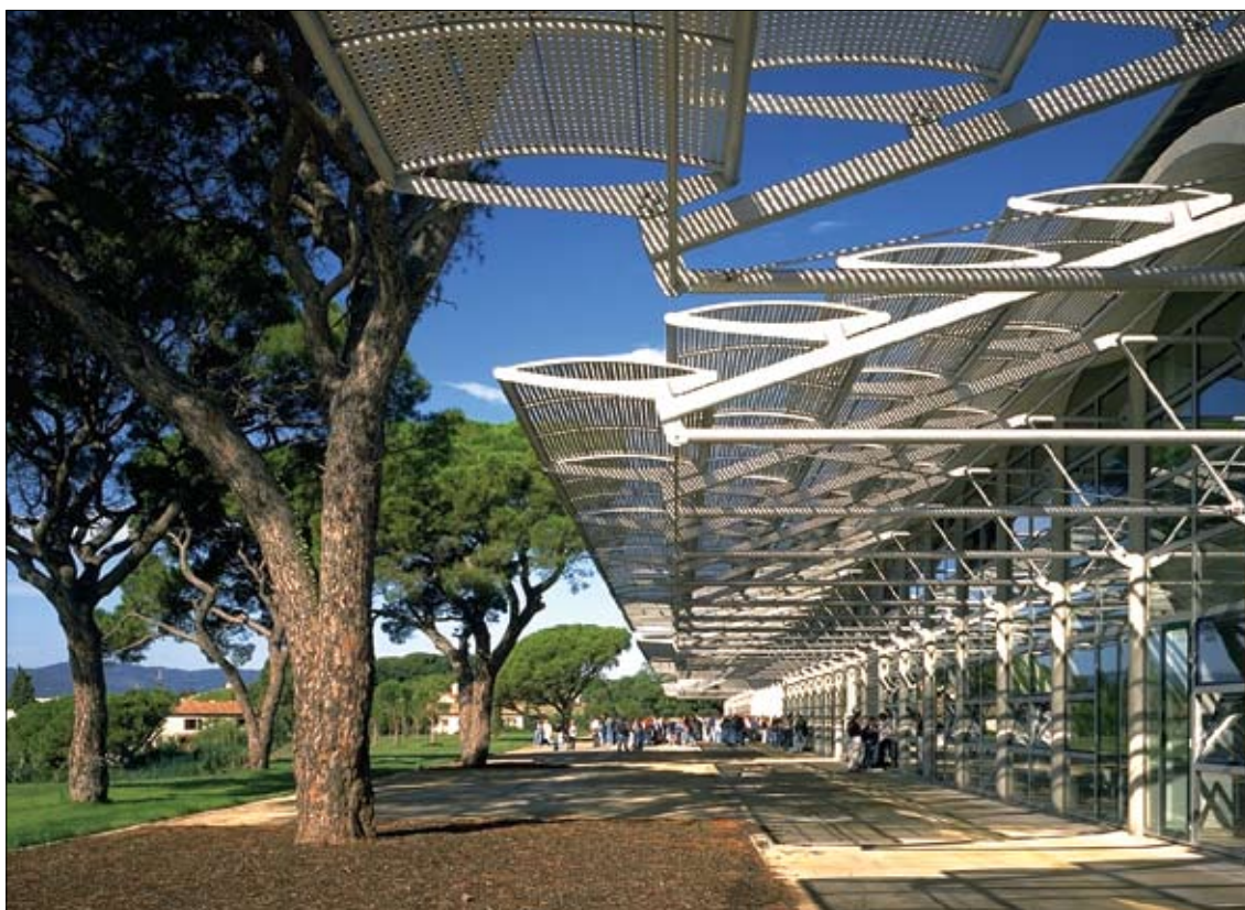
Senčniki na južni fasadi srednje šole Alberta Camusa v Frejusu v Franciji, projekt biroja Foster & Partners, kjer je v osrednjem hodniku zgradbe aktiven učinek sončnega dimnika. Osrednji del podolgovate zgradbe je namenjen pretoku ljudi in toplega ter hladnega zraka, zato 240 metrov dolgega hodnika ni treba ogrevati, razredi pa so pred močnim mediteranskim soncem zaščiteni z estetsko dovršenimi senčniki. Fotografija: Nigel Young/ Foster + Partners
