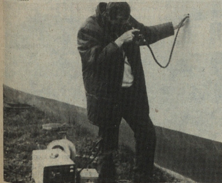
Jože Sovič je opravil endoskopski pregled vrtin v zidu, da je lahko ugotovil sestavine in stanje v notranjosti (poroznost, razpoke).
