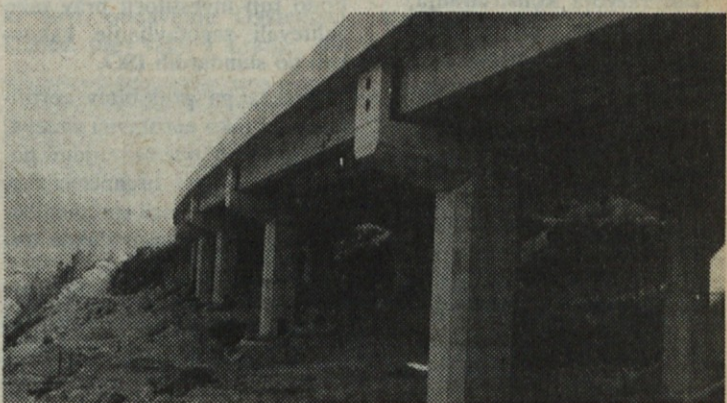
Stebri za viadukte stojijo na vodnjakih, ki so še dodatno sidrani v brežino, ki ima ponekod 22 in več stopinj naklona. Sidra so dolga tudi do 20 metrov.
