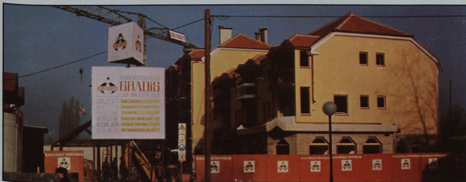
Poslovno-stanovanjski objekt nasproti avtobusne postaje v Žalcu gradijo delavci Gradbenega podjetja Celje. Gre za gradnjo za trg, ki poteka v več fazah. Na posnetku je prva faza, ki je tik pred dograditvijo.
