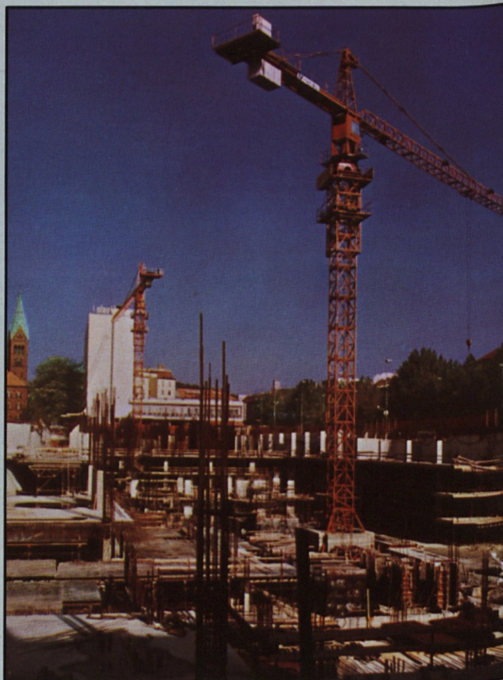
Gradbišče podzemskih garaž in hotela pri Slaviji v Mariboru čaka na boljše čase. Kdaj bodo z delom nadaljevali, ne ve nihče.
