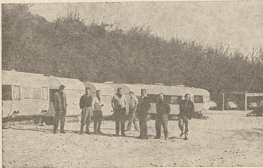
Delavci gradbišča TOZD RGD v Podsusedu so v glavnem stanovali v stanovanjskih prikolicah. Po ukinitvi gradbišča, je ta TOZD prepustila prikolice članom kolektiva za letovanje v Novigradu.
