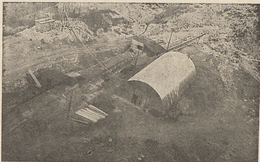
Posnetek gornjega dela gradbišča TOZD RGD v Podsusedu. Posnetek kaže vhod v predor-vpadnik. Foto S. Marković
