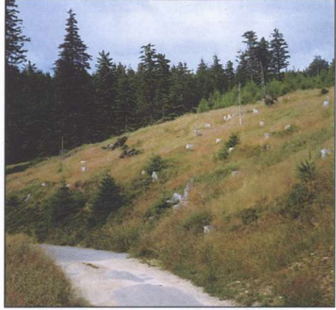
Slika 5: Kopičenje erodiranega materiala na delu ceste, ki poteka v smeri plastnic (foto: Simon Kušar).
