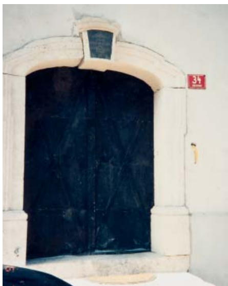
Protipožarna vhodna vrata na Levičnikovi, danes Debevčevi hiši. (foto: Alenka Zupanc Rižner)
